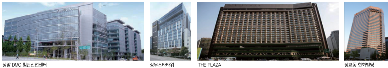
상암 DMC 첨단산업센터 상무스타타워 THE PLAZA 장교동 한화빌딩
